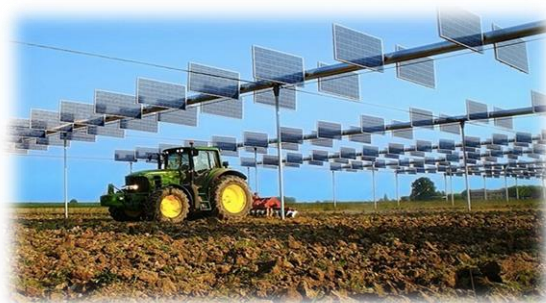
Figura 2: coltivazione del terreno più fotovoltaico.
