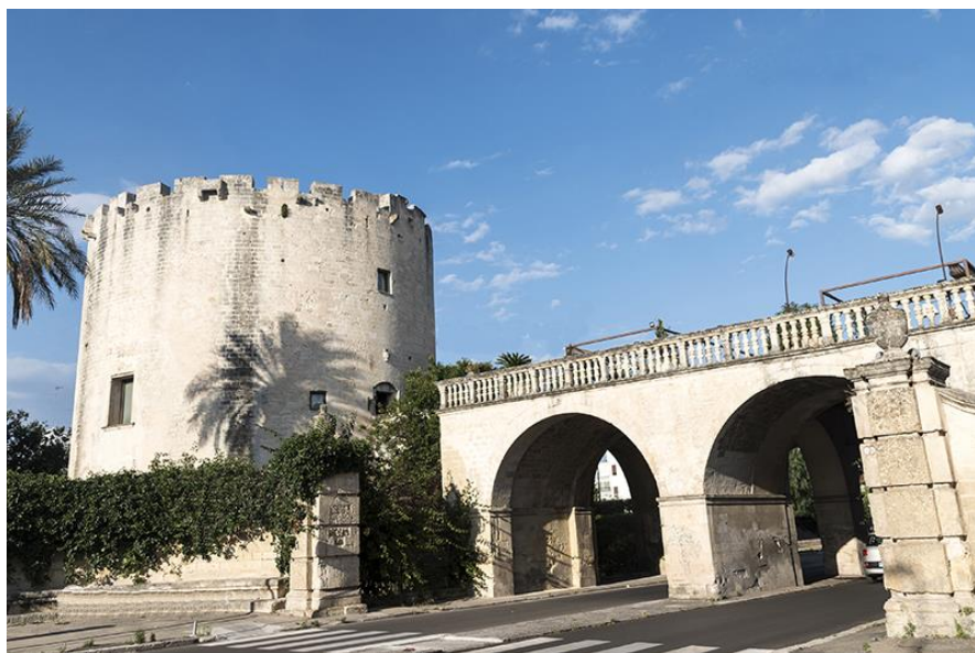
FIG. 15. Lecce, Torre del Parco
