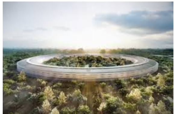
Fig. 3 - Il progetto dell'Apple Campus 2, in corso di realizzazione a Cupertino
