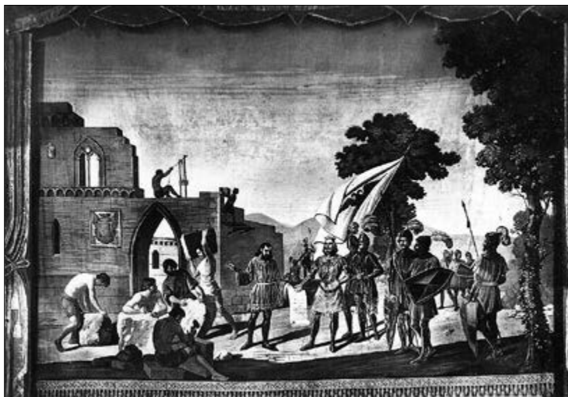
Fig. 8. - Nicola Montgano, Federico II controlla i lavori di costruzione della Cattedrale di Altamura , sipario dipinto proveniente dal demolito Teatro Comunale oggi nel Teatro Mercadante di Altamura.
