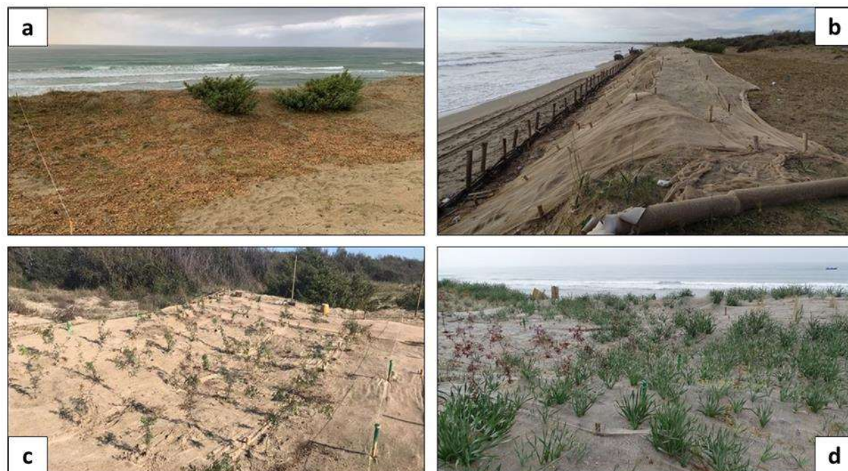
Figura 3.7 Operazione di pacciamatura della superficie della duna (a); posa di bioreti (b); esemplari di Pistacia lentiscus (L.) messi a dimora su duna (c); sviluppo di Pancratium maritimum (L.) ad un anno dal termine dei lavori (d).
