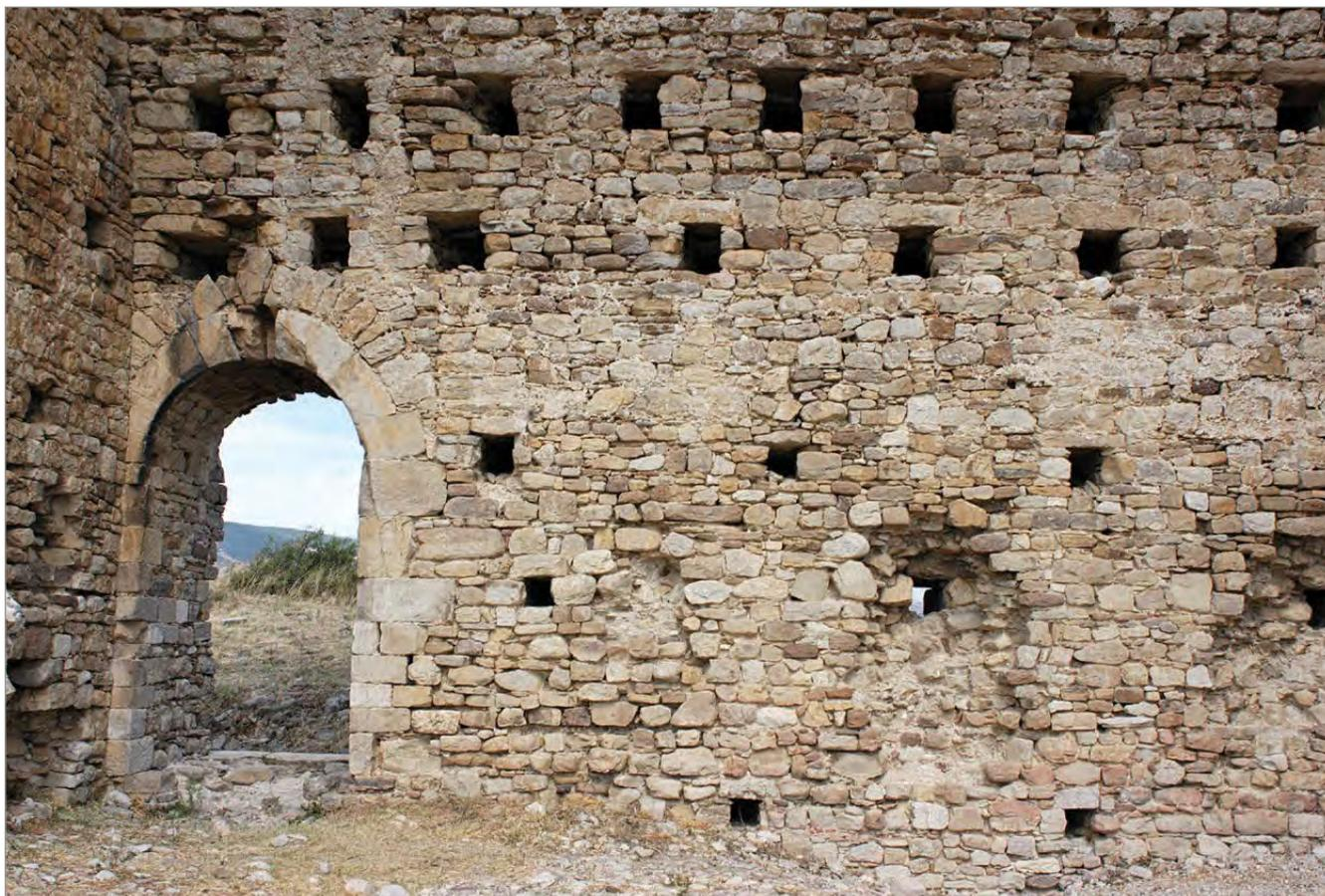
fig. 14 – La doppia sequenza di fori per il supporto della centina della volta nella torre di Montecorvino, ben distinguibili dalle buche pontaeie, visibili più in basso nella parete (foto Archivio Scavi Montecorvino).
