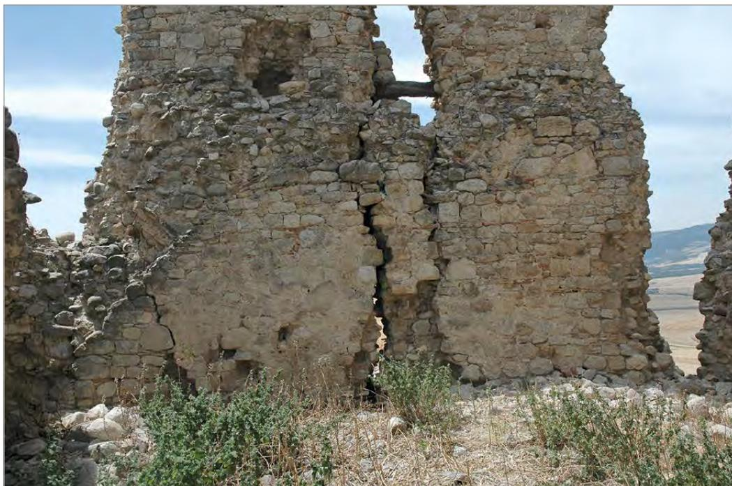
fig. 6 – Muro della torre di Tertiveri attraversato da una trave lignea (foto di R. Giuliani).
