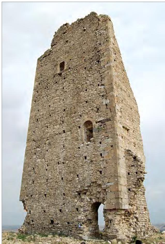
fig. 11 – Torre di Montecorvino su cui sono ben visibili le sequenze ordinate di fori pontai (foto Archivio Scavi Montecorvino).
