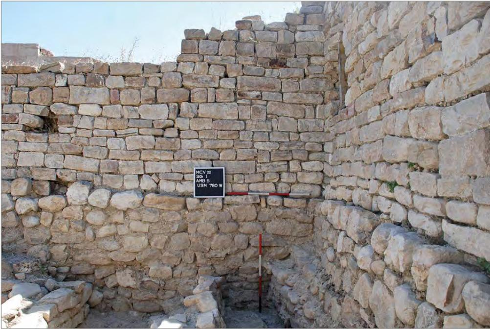
fig. 1 – Le fondazioni dell’amb. 5 dell’episcopio di Montecorvino; sulla destra il muro meridionale con riseghe progressivamente aggettanti; di fronte il muro est con un’unica risega poco sporgente (foto Archivio Scavi Montecorvino).
